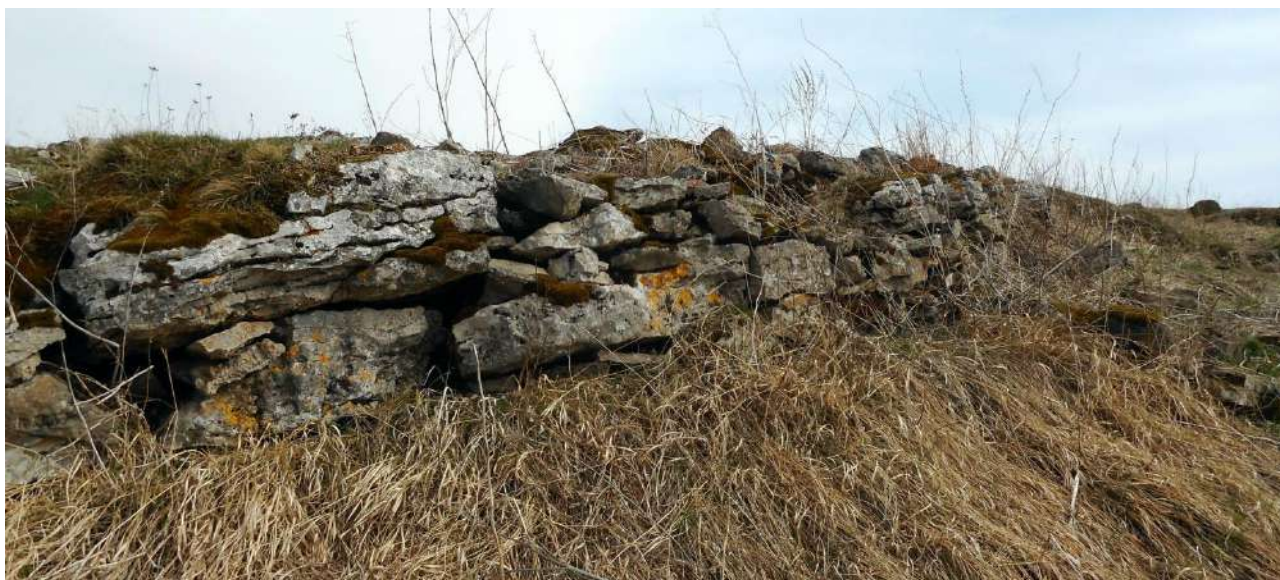
Рис. 6. Подпорная стенка старинной дороги на городище Уллу-Дорбунла. Снимок В.С. Яновского, 2019 г.
